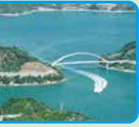
岡村大橋(橋長:228m)
