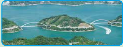
中の瀬戸大橋(橋長:251m)
